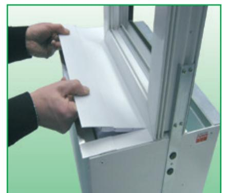
Verschlussdeckel in die Traverse auf dem Fenster schieben und Adapterprofil wieder in die Clipschiene drücken.
