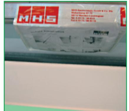
Den Beipackbeutel mit den Kunststoffdübeln und den Sicherungsschrauben von der Außenschiene abnehmen.
