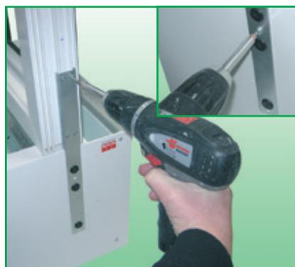
Den **isy® Rapid** Rollladenkasten parallel zum Fenster auflegen und verschrauben. Ab 200 cm Kastenlänge mit Sicherungsschraube ③ zusätzlich befestigen.
