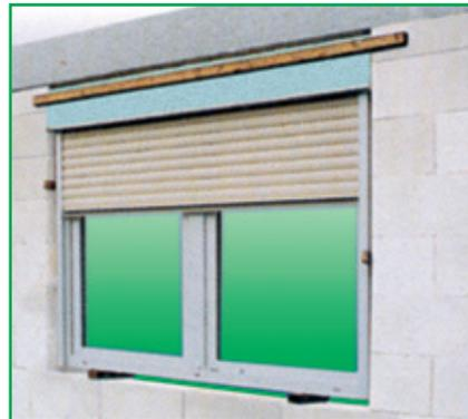
Als äußere Montagehilfe eine Dachlatte auf der Wand befestigen.
